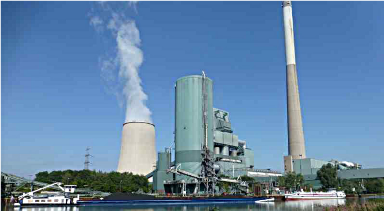
Das Steinkohlekraftwerk in Heil.
