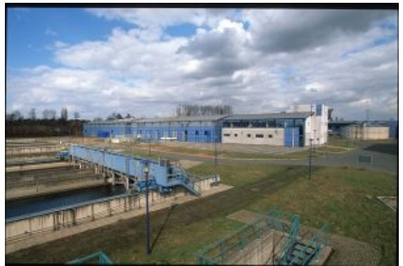
Die Kläranlage (KLG) Kamen-Körnebach.
