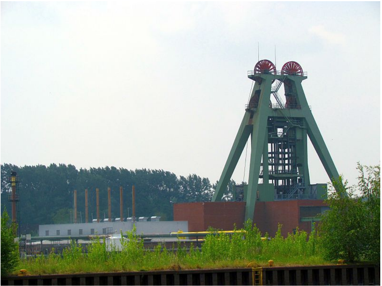
Das Schachtgerüst Haus Aden 2 .
