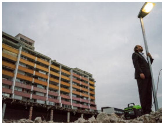
Fast schon historisch auf der City-Baustelle.
