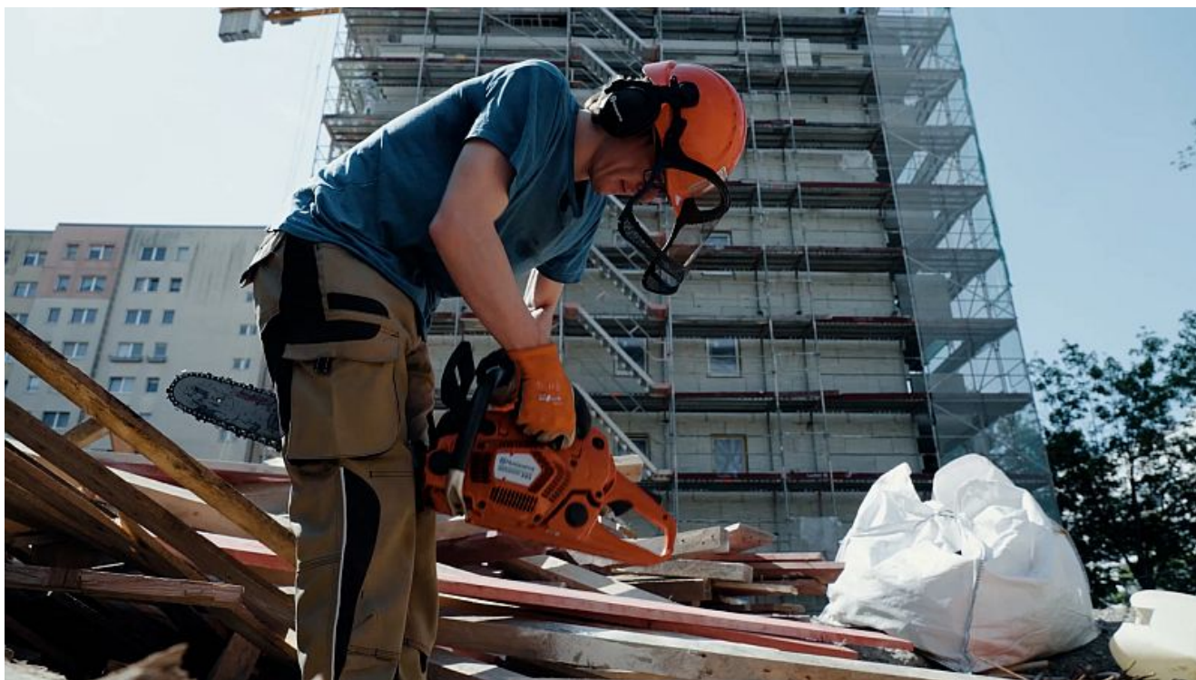
Foto: IG BAU
