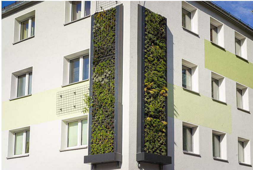
Fassadenbegrünung Gladbecker Straße in Essen
