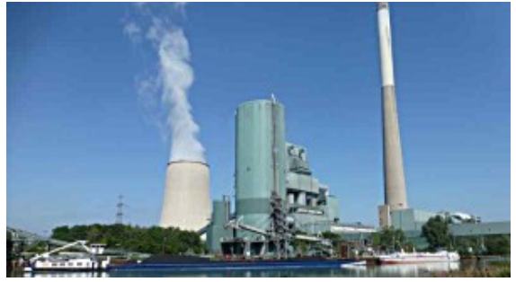
Das Steinkohlekraftwerk in Heil.
