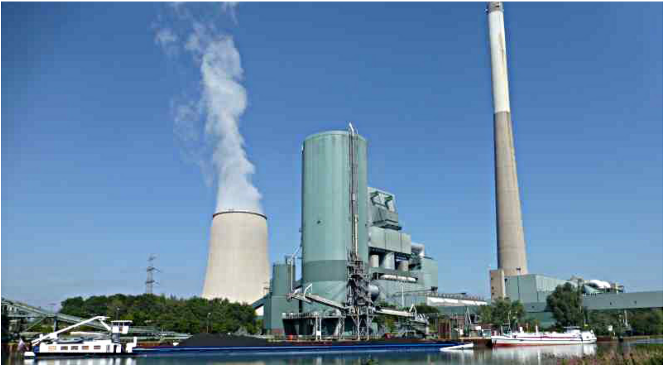
Das Steinkohlekraftwerk in Heil.
