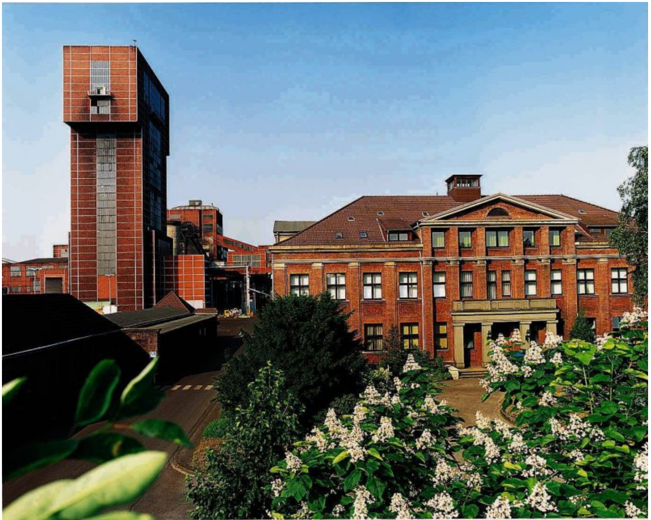
Ehemaliges Bergwerk Ost in Hamm
