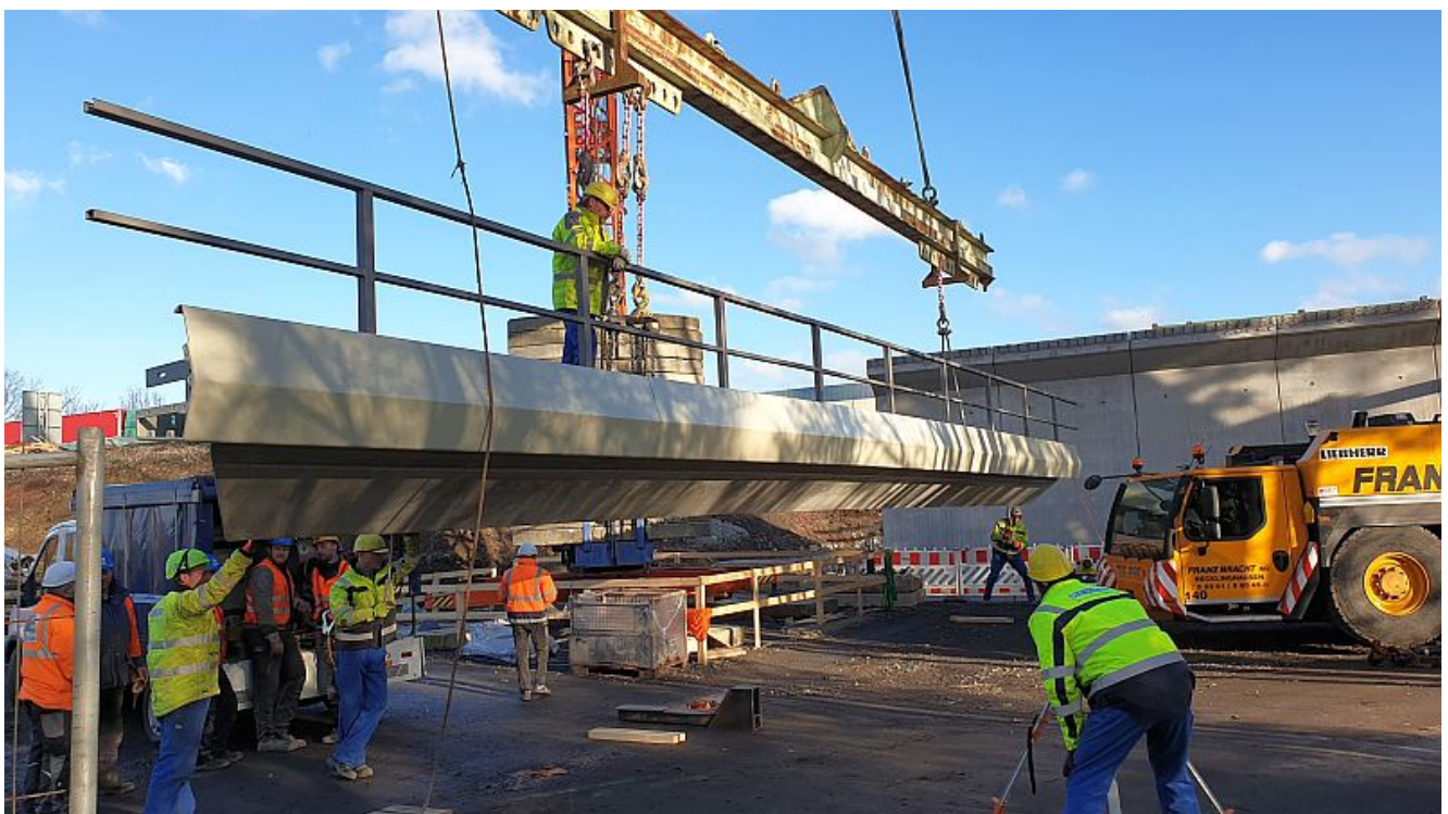
Pilotprojekt A1 Afferder Weg: Einheben der Hybridkappe. Foto: Straßen.NRW
