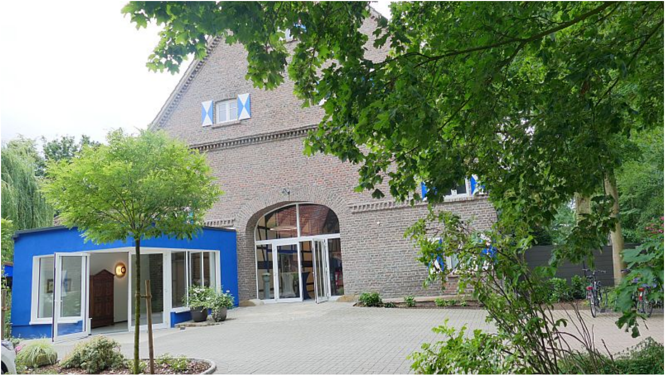
Das 1860 gebaute Haupthaus des Hofes Middendorf in Overberge.
