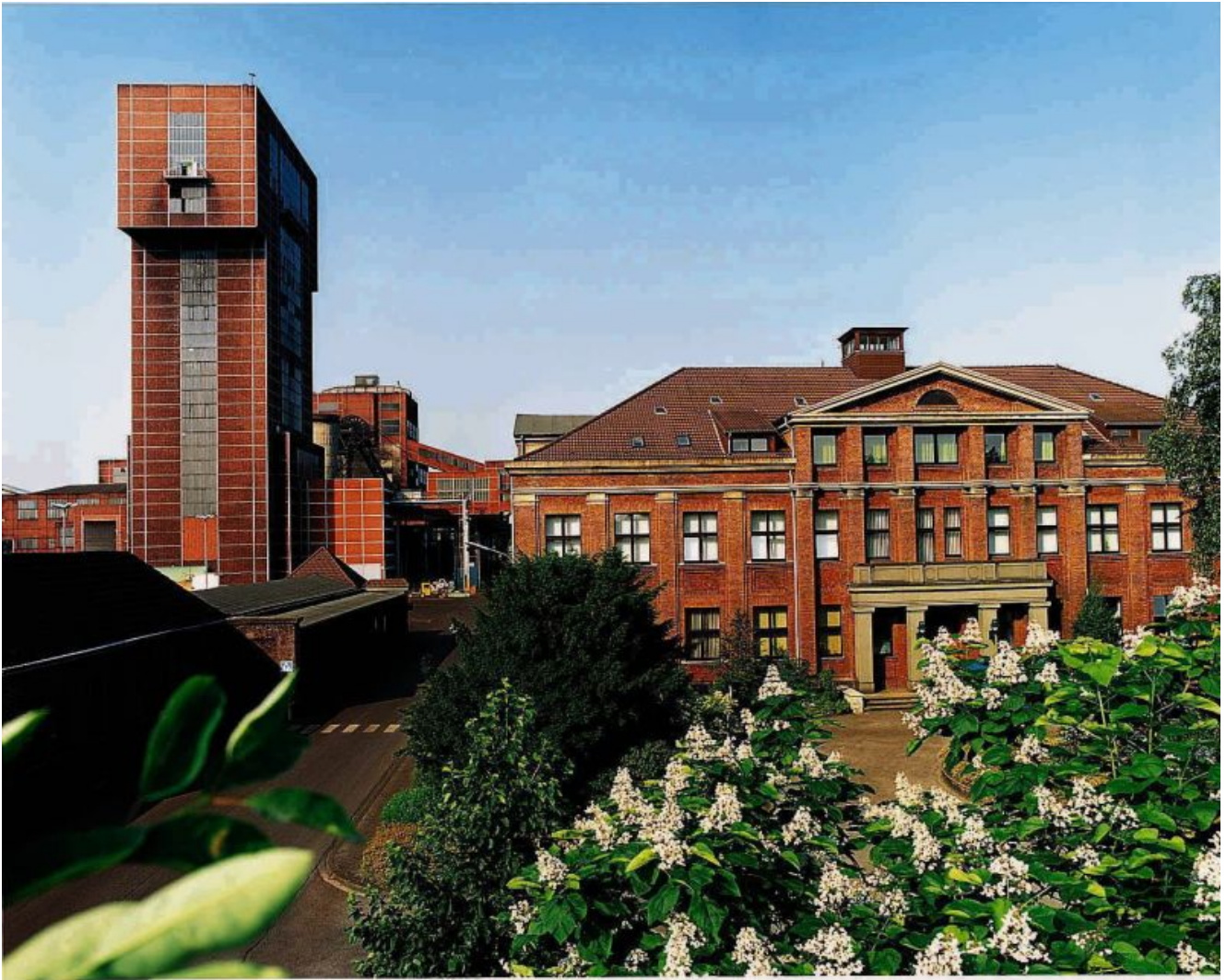
Ehemaliges Bergwerk Ost in Hamm
