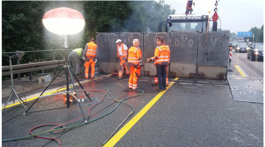
Mit mobilen Stahlplatten kann flexibel gearbeitet werden. Foto: Straßen NRW
