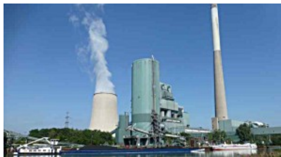
Das Steinkohlekraftwerk in Heil.
