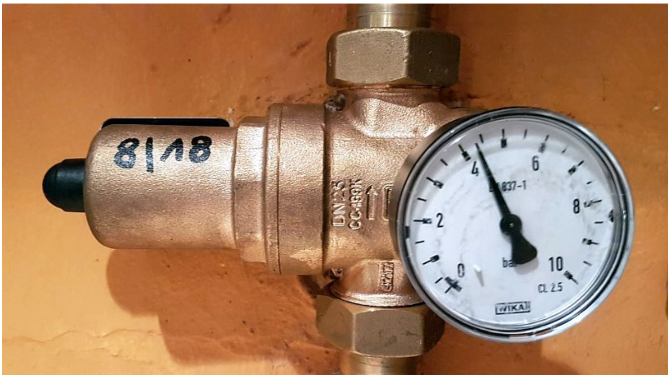
Druckminderer mit Manometer.
