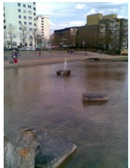
Die Wasserspiele im Wasserpark im Probelauf
