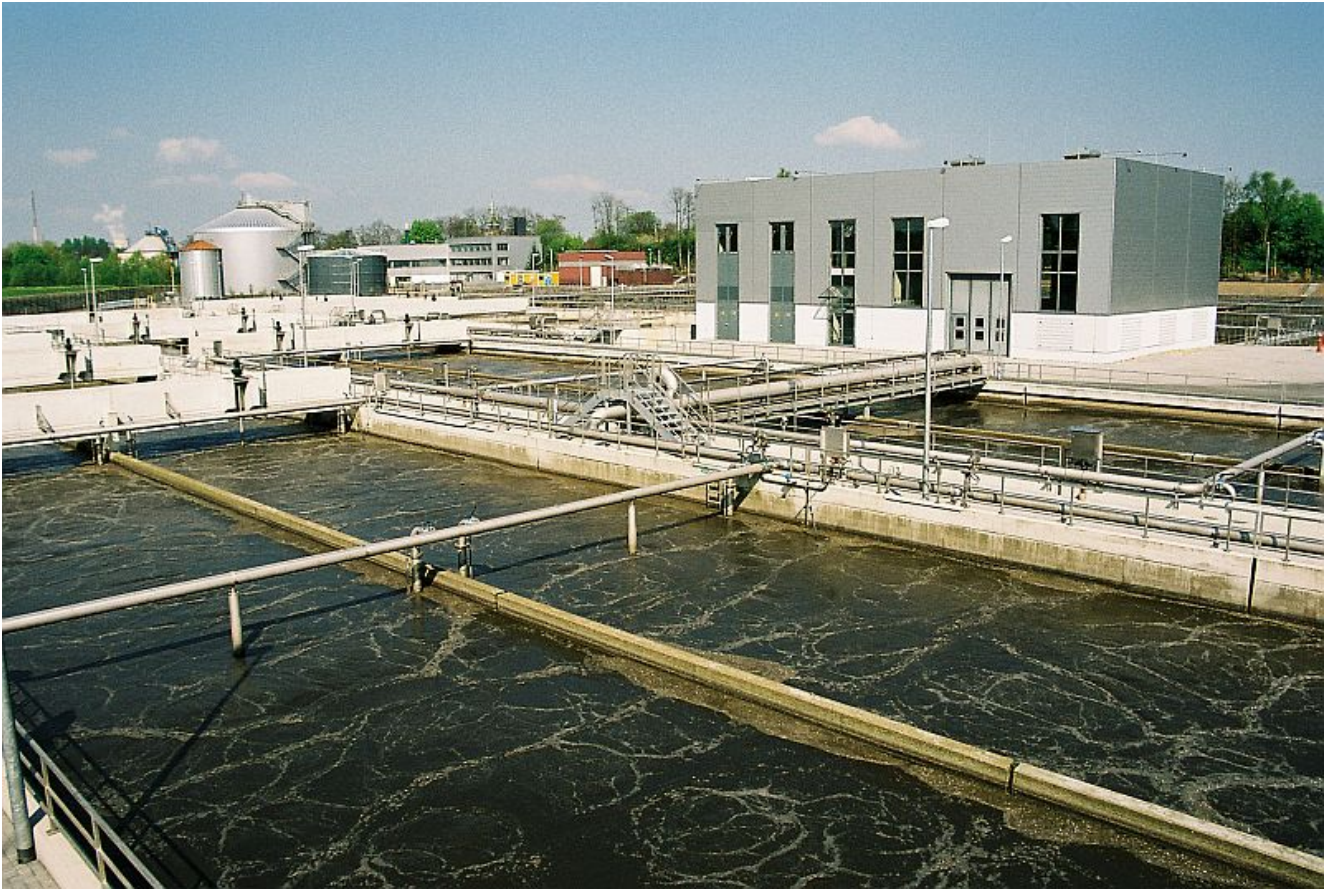
Kläranlage Lünen. Foto: Lippeverband
