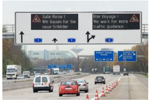
Solche dWiSta-Tafeln sollen an der A1 jetzt errichtet werden, Foto: Straßen.NRW
