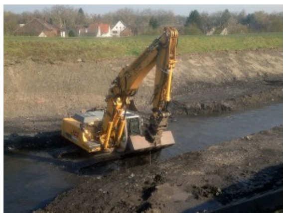
Bagger im Unterlauf der Seseke
