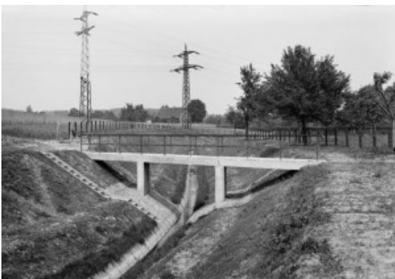
Fußgängerbrücke über dem
