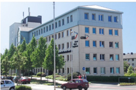
GSW-Gebäude in Kamen.
