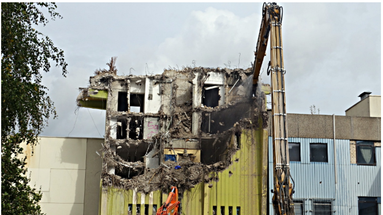
Aktuelles Foto vom Wohnturm-Abriss.
