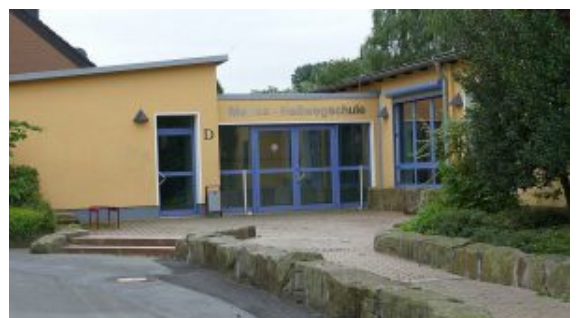
Die Mensa und die Turnhalle
