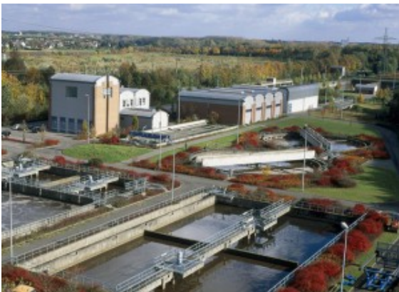
Kläranlage des Lippeverbands in Scharnhorst
