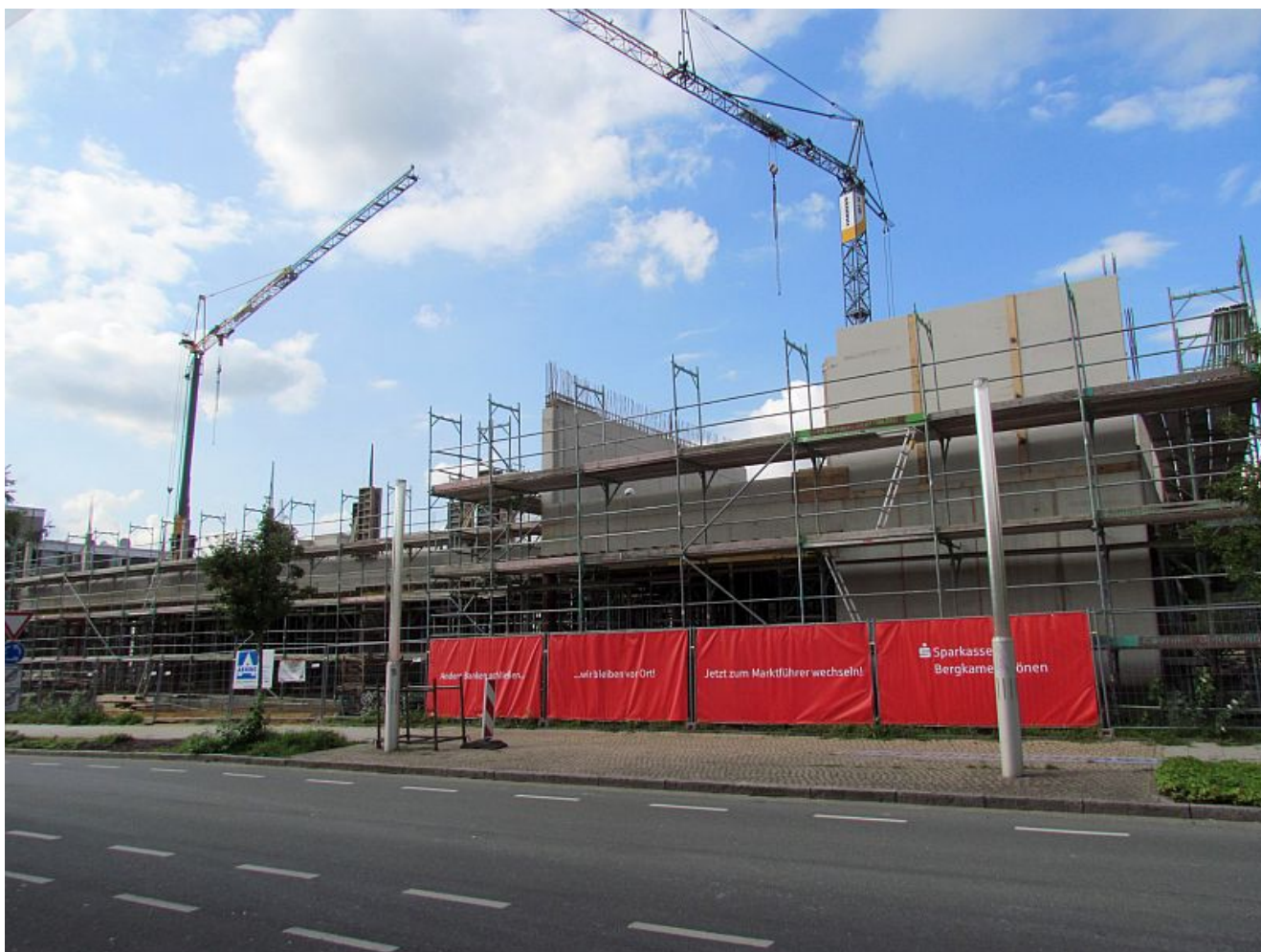
Die Baustelle für die neue Hauptstelle der Sparkasse
