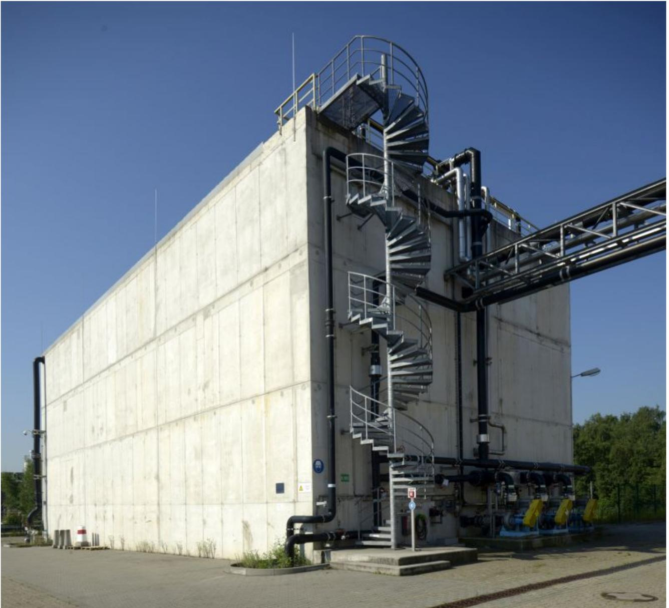
Der Pufferbehälter der Kläranlage ist mehr als 27 m lang, 11 m hoch und verfügt über ein Fassungsvermögen von 5.000 Kubikmetern Abwasser.
