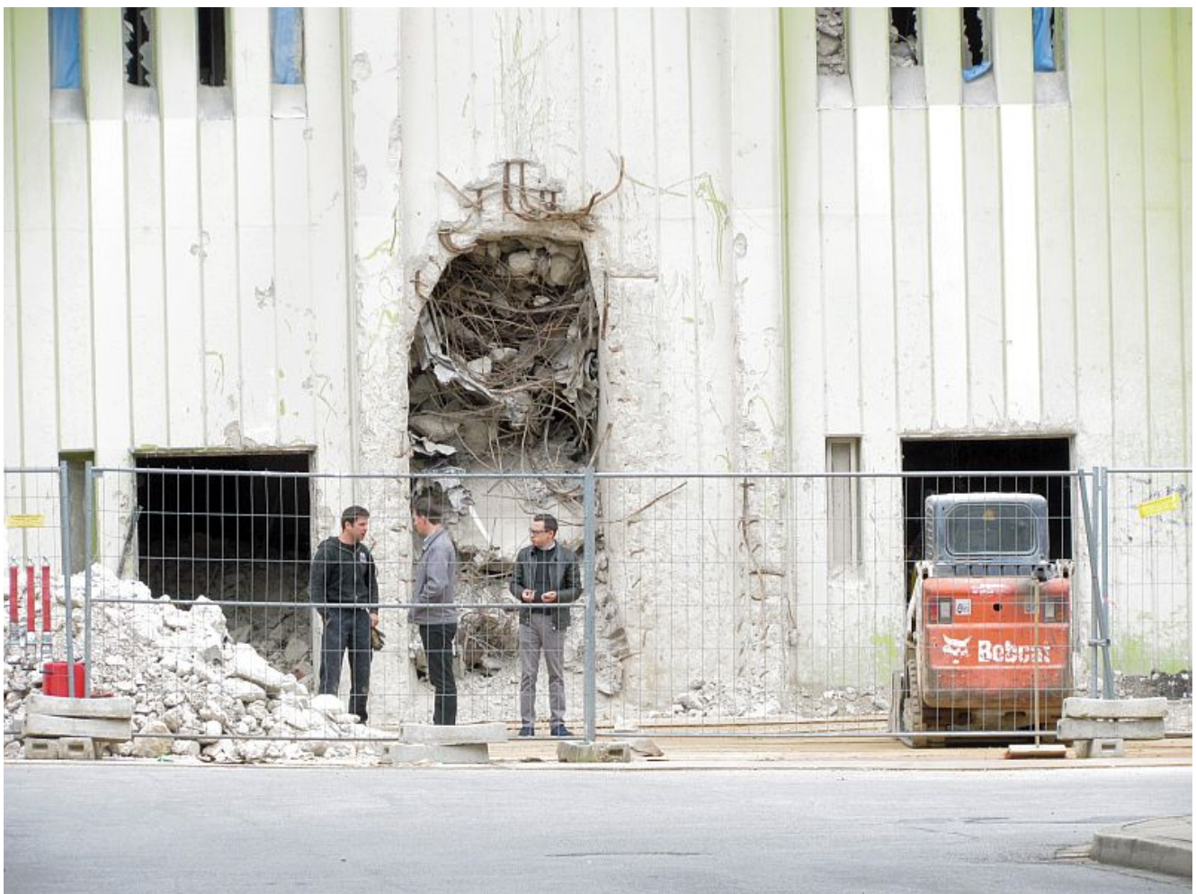
Die Eingänge zum Wohnturm-Stumpf werden frei gelegt.
