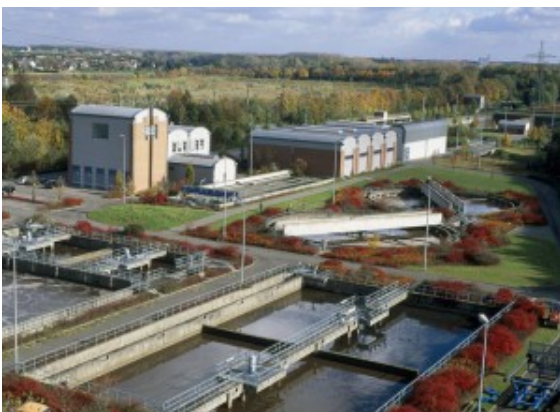
Kläranlage des Lippeverbands in Scharnhorst
