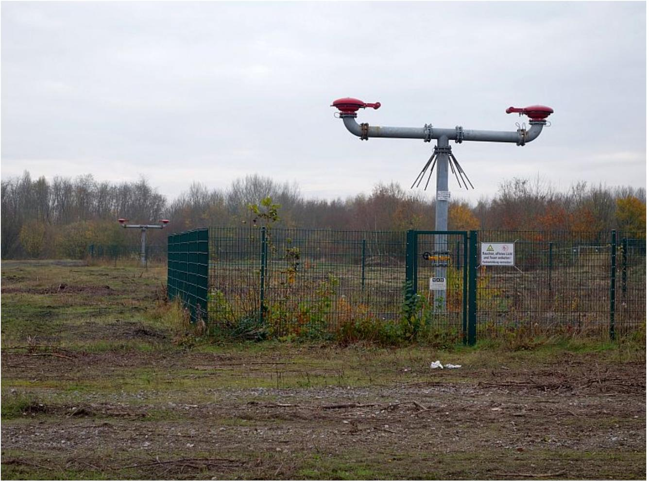
An den Gasabzugsanlage sind die Standorte der beiden Grimberg-Schächte heute zu erkennen. Die vordere Anlage gehört nicht mehr zum neuen Baugebiet.
