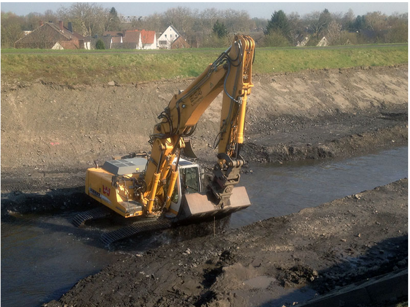
Bagger im Unterlauf der Seseke
