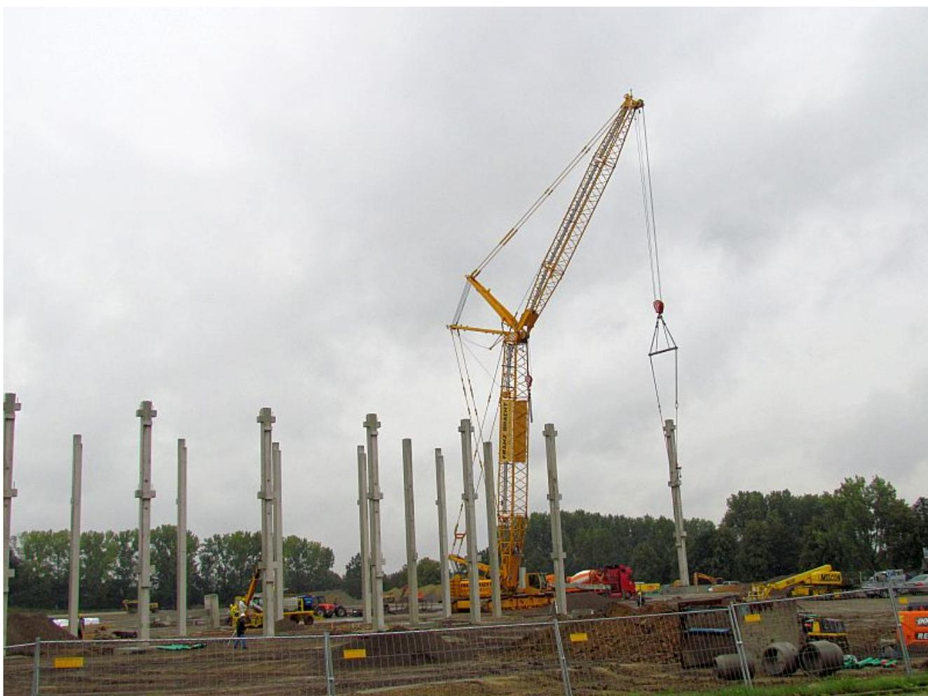
Die bis zum 20 Meter hohen Betonträger werden fertig angeliefert und auf die bereits gegossenen Fundamente gesetzt.
