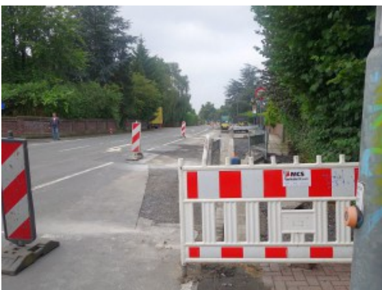
Restarbeiten auf der Landwehrstraße im Bereich der Kamer Heide.
