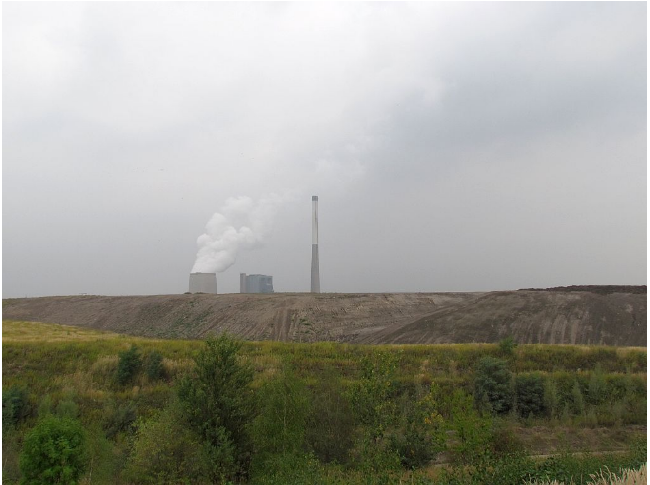
Haldenpanorama mit Kraftwerk
