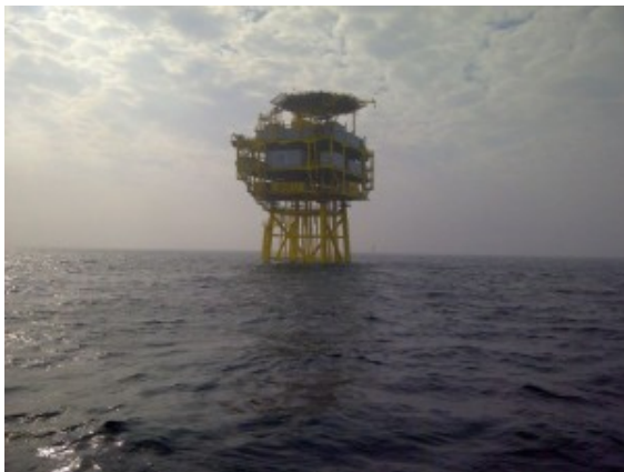
Die Umspannplattform in der Nordsee vor Borkum.
