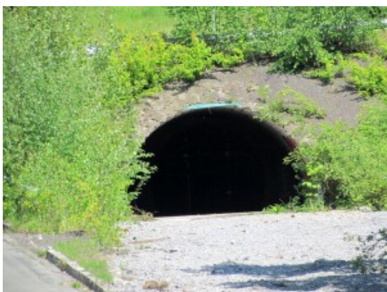
Der Eingang zu Tunnel in
