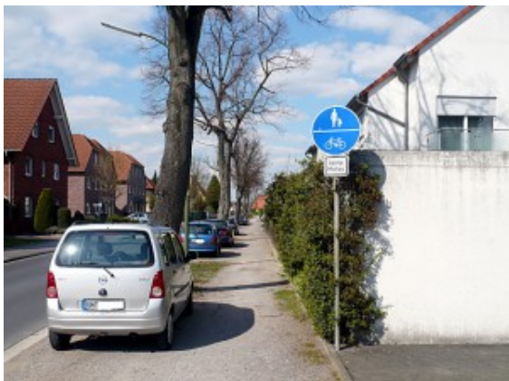
Der Schotter auf dem Gehweg
