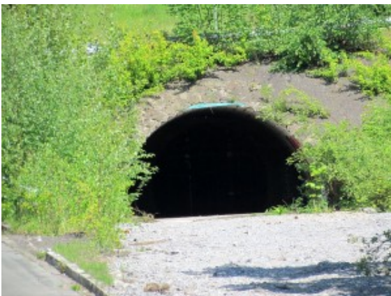
Der Eingang zu Tunnel in
